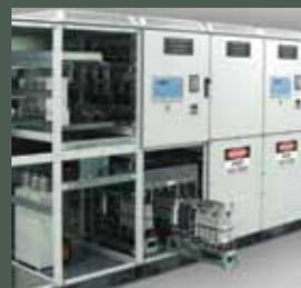
为中压电机配备的成熟的电机管理系统。MVS软起动器提供全系列的软启动控制，电机/负载保护及其他功能。
