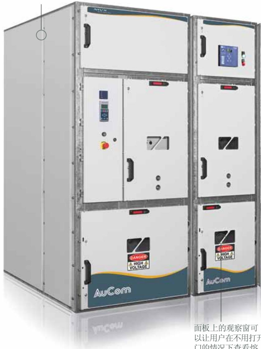
面板上的观察窗可以让用户在不用打开门的情况下查看熔断器，接地开关等
